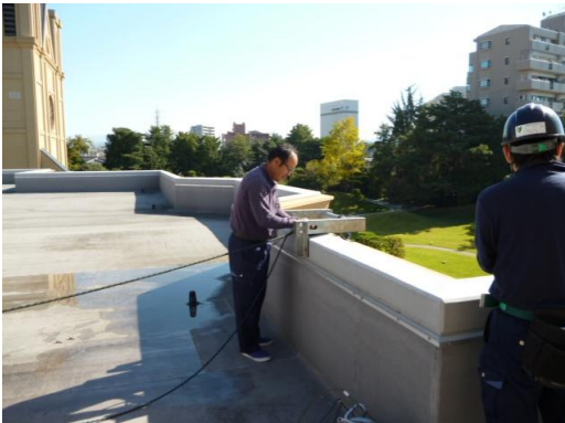
パラペットの一部が発砲スチロール製のため、特殊な架台を使用
